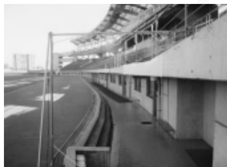
↑主競技場の第4コーナー付近に設置されているミストシャワー
